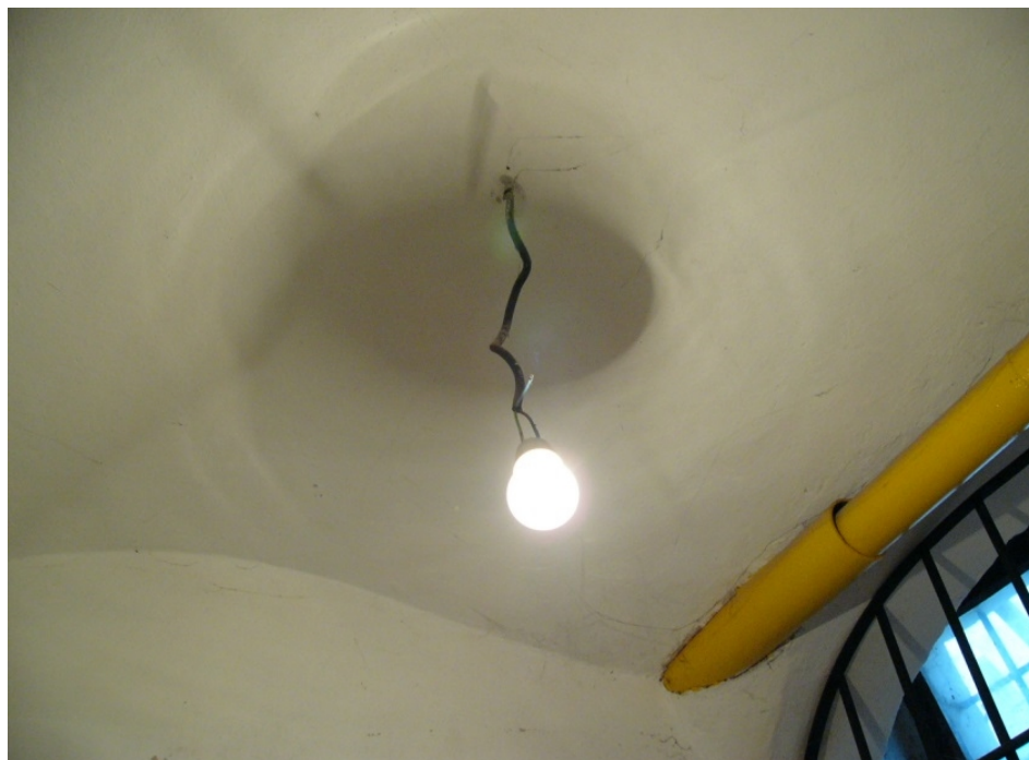
Obr. 2 Neodborne nainštalované osvetľovacie teleso v miestnosti regulačnej stanici plynu
