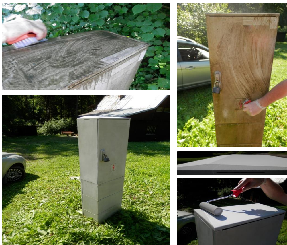
Obr. 9 Renovácia RS (čistenie/multiclean a náter)
