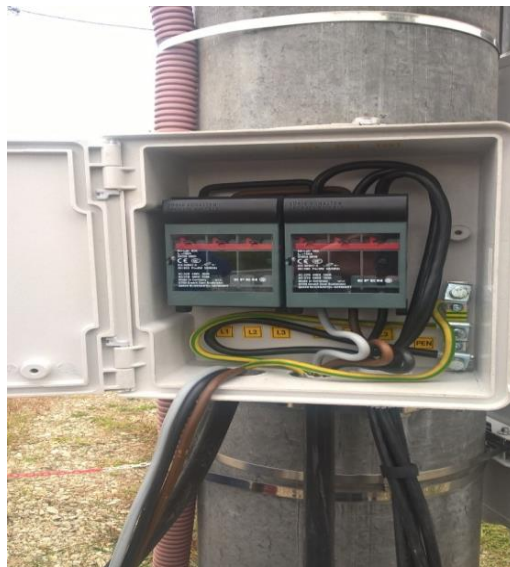
Obr. 3 Nové riešenie (poistkové odpínače)
