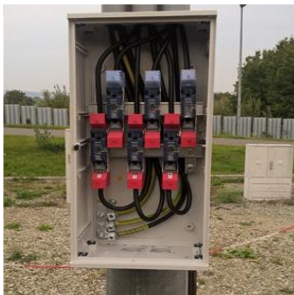
Obr. 3 Nové riešenie (poistkové odpínače)
