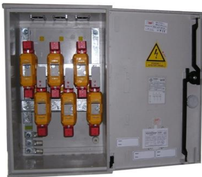
Obr. 4 Existujúce riešenie (poistkové spodky)
