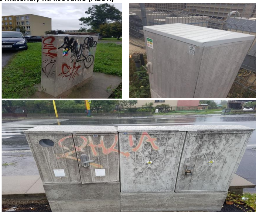
Obr. 7 Príklady RS po rokoch používania
