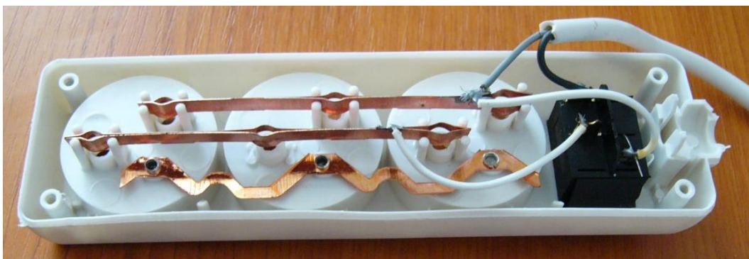
Obr. 4 Nevyhovujúci predĺžovací šnúrový prívod - dvojšnúrový (chýba vodič PE)
